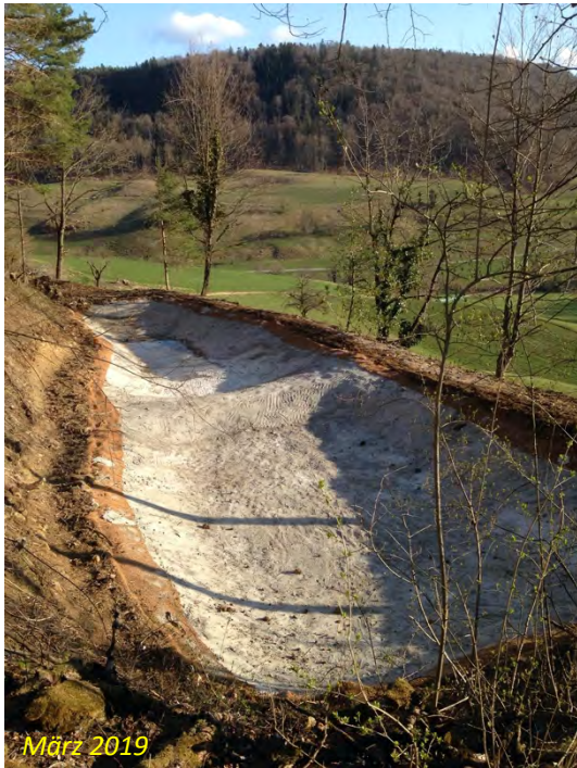
Nach der fertiggestellten Sanierung (noch ohne Wasserzulauf): Schutzmörtel (grau), die angemörtelte Kokosmatte am Teichrand (hellbraun ) wird sich bewachsen und verhindert einen scharfen, trockenen Übergang vom Wasser zur Böschung.
