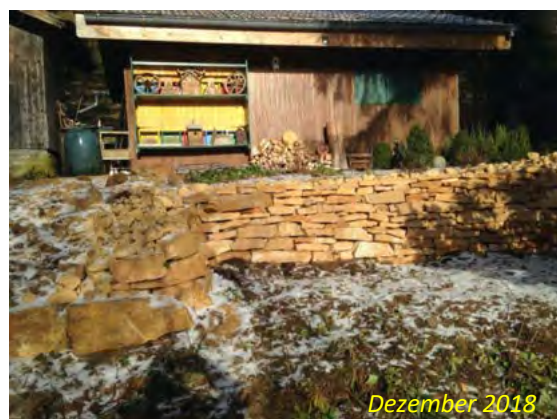
Die zerfallene Mauer beim Bienenhaus wurde durch eine Trockensteinmauer mit schmalen Kalksteinplatten neu aufgeschichtet.
