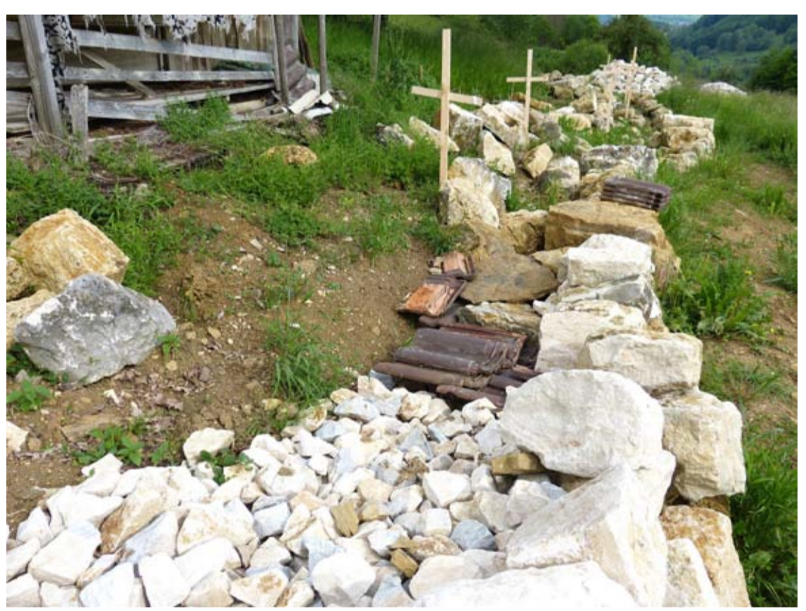
Trockenmauer im Bau
