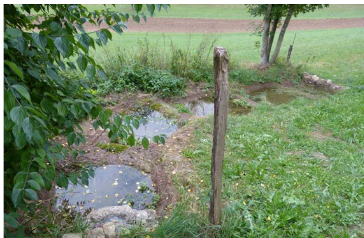
Der untere Teil im flacheren Gelände wurde Ende August 2016 fertig und mit Wasser- und Sumpfpflanzen von Bächen aus der Nähe bepflanzt. 4. 9. 2016
