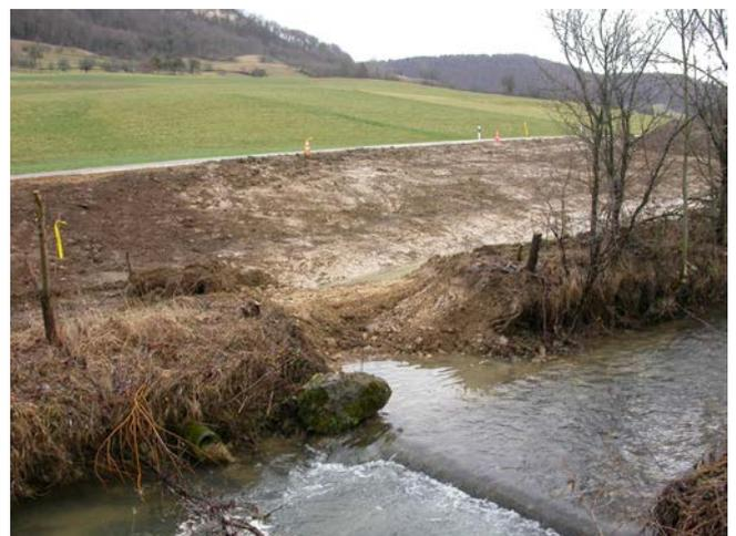
Bauarbeiten: Aushub des Altarms und Durchbruch zur Ergolz
